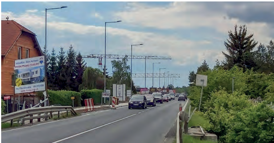
Ulice Pražská během finální fáze stavby chodníku.
