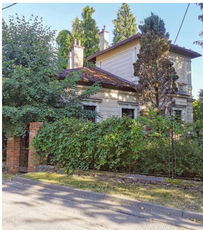
Pohled na západní stranu domu z Tyršovy ulice
